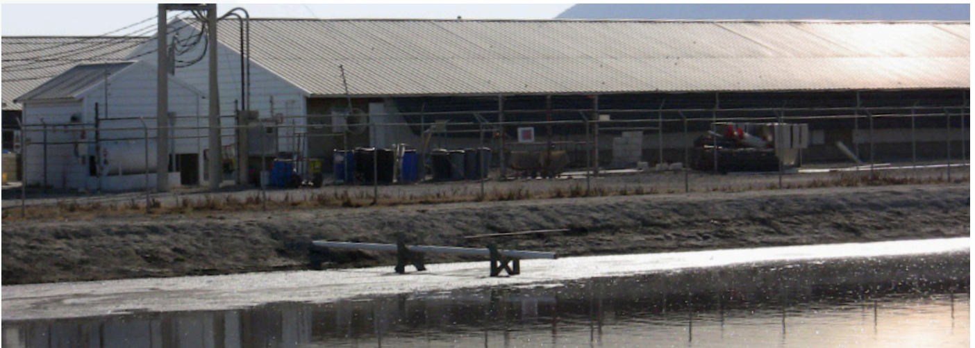
Galpão de confinamento de suínos junto a lagoa de oxidação, onde os dejetos são depositados
